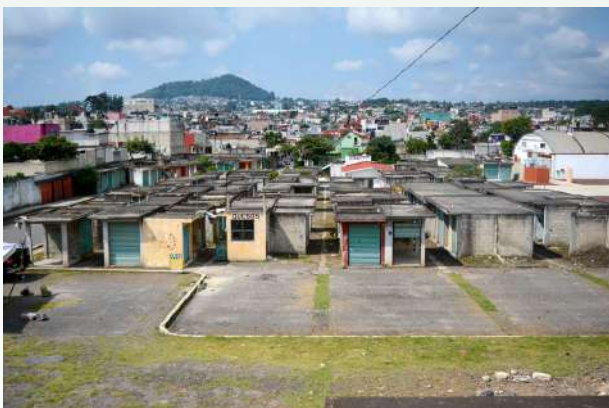
Fotografía tomada de: e-colsulta.com Veracruz https://e-veracruz.mx/nota/2019-12-16/xalapa/tras-demolicion-de-mercado-construiran-centro-cultural-en-el-moral
